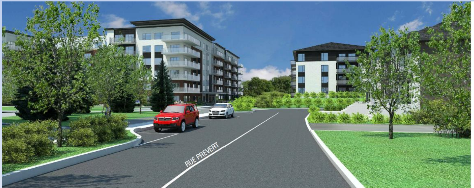
VUE DE LA RUE PREVERT VERS L'EDIFICE (C)
